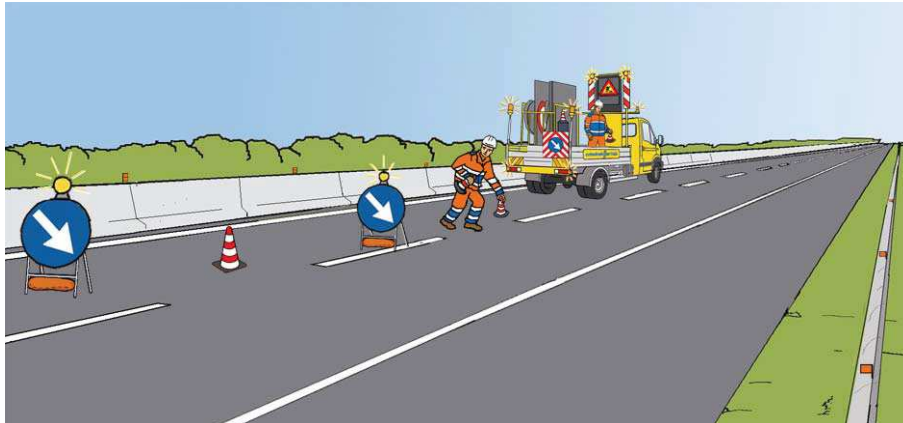
Figura 43 – Chiusura della corsia di sorpasso: inizio della posa dei coni
