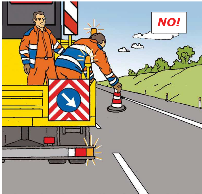
Figura 60 – Posizionamento dei coni o defleco: comportamento scorretto
